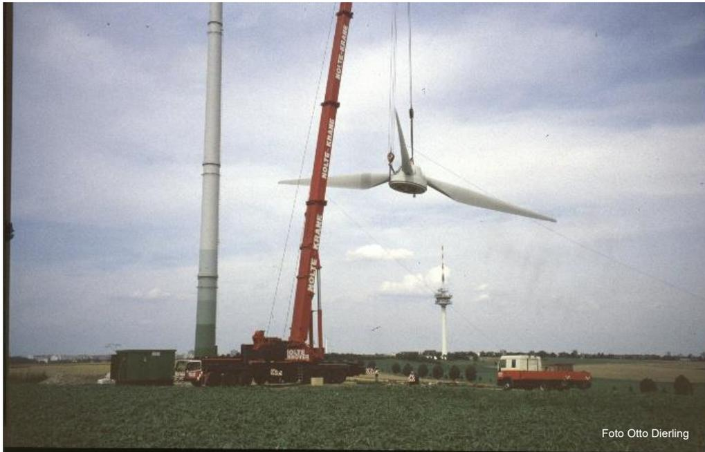
Die E-40 hat eine Nennleistung von 500 Kilowatt oder 0,5 Megawatt. Die Nabenhöhe (dort, wo das Maschinenhaus ist) beträgt 55m, die Gesamthöhe liegt bei 75 Metern und der Rotordurchmesser beträgt 40m. Im Jahr 2021 hat diese Anlage 680.000 Kilowattstunden elektrische Energie produziert.
